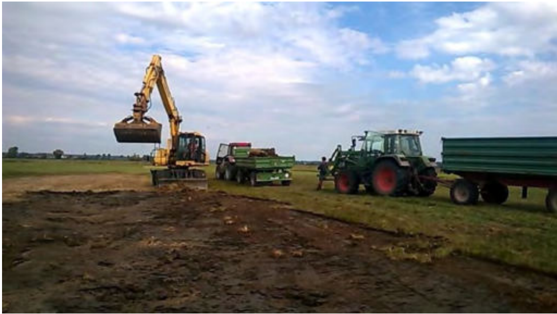
Abb. 74: Neuanlage von Flachmulden im Wiesmet und Abtransport des Aushubs durch örtliche Landwirte
